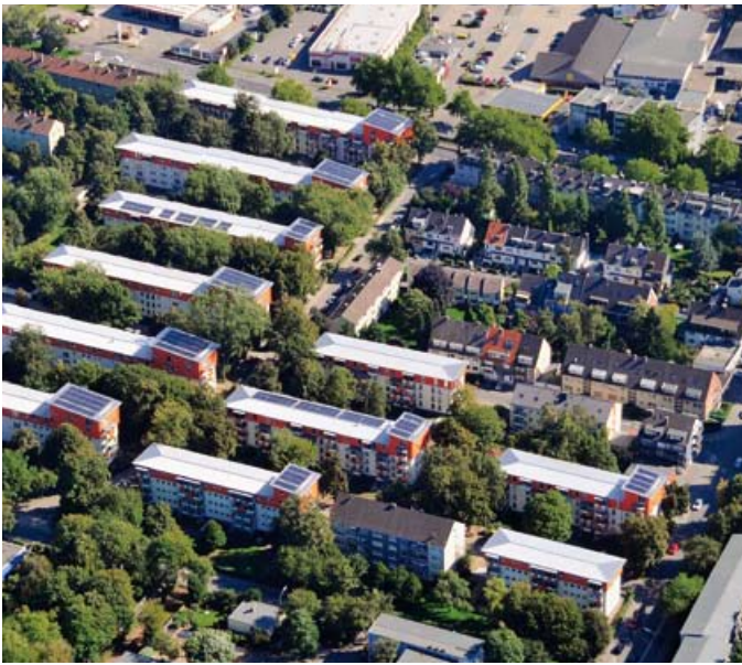
▲ Im Luftbild sind die elf modernisierten und aufgestockten Gebäude gut zu erkennen. Acht erhielten an einem Ende zwei Geschosse
